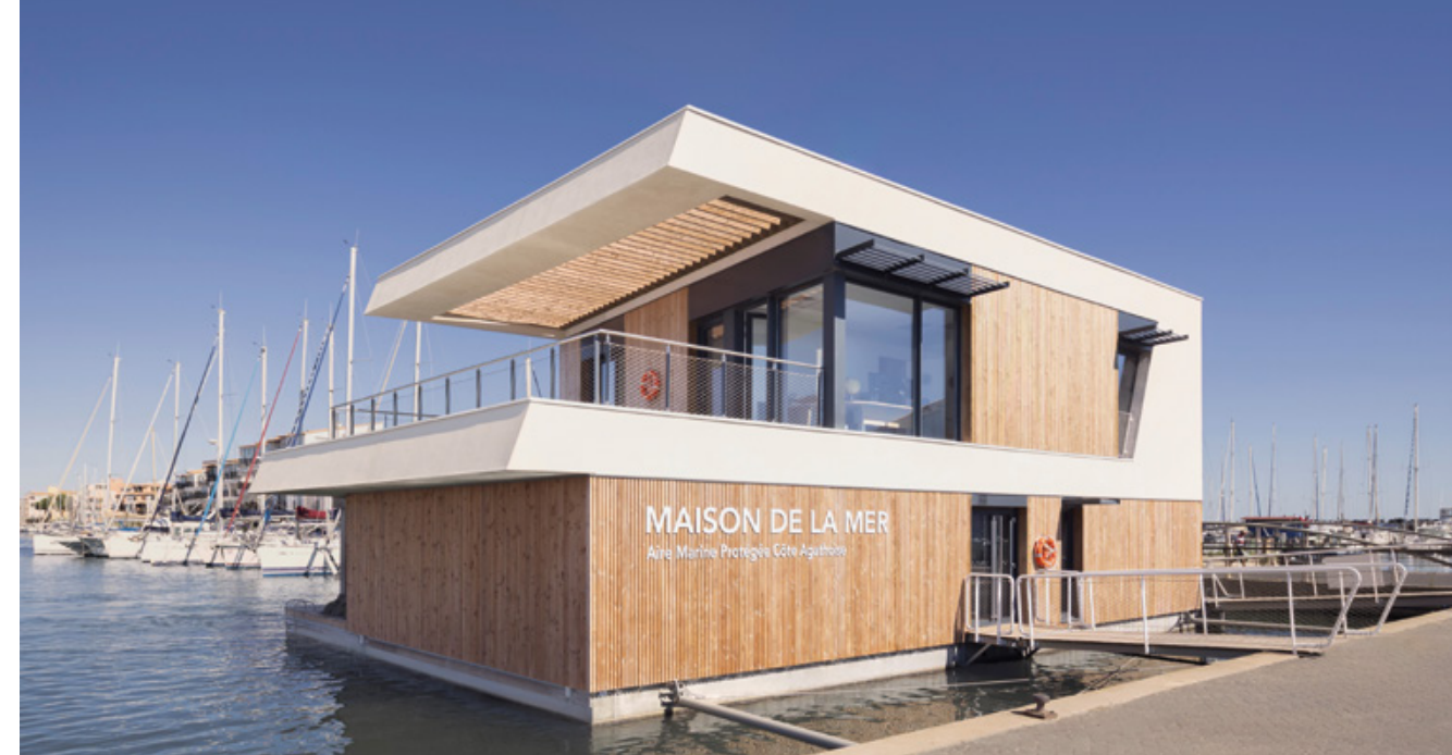
Maison de la mer au vieux port du Cap d'Agde (34) - Agence IMAGINE architectes de Montpellier
